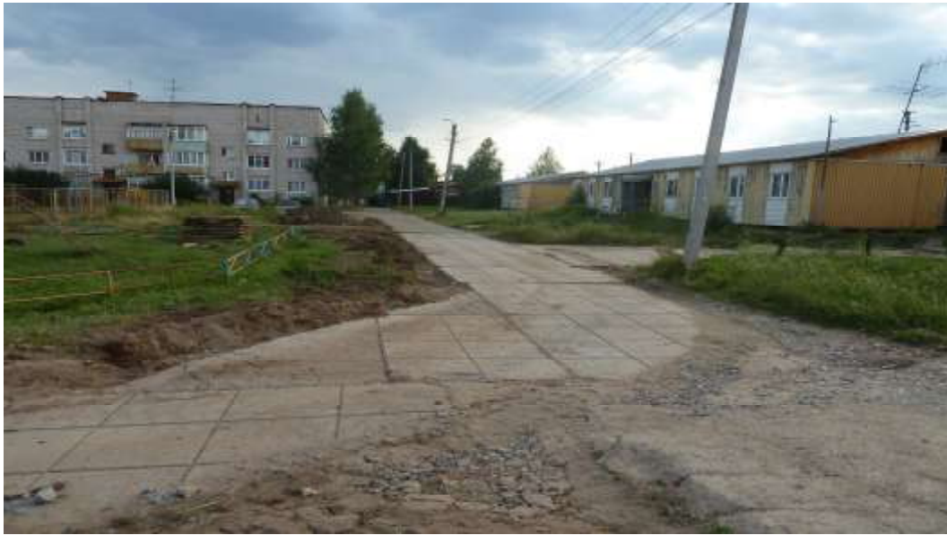
мкр. Компрессорный, 2 (до)
